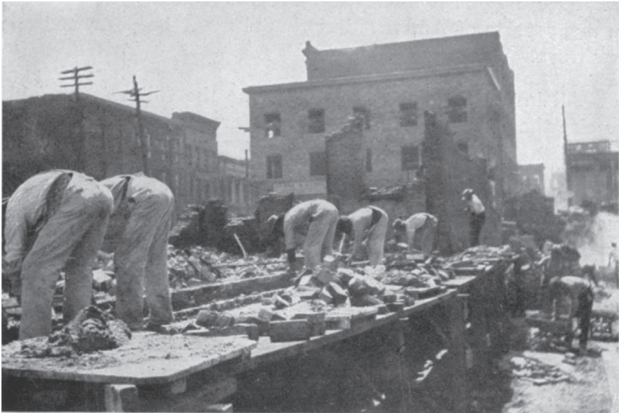
Abb. 8 b: Gilbreth: Baustellenfoto
