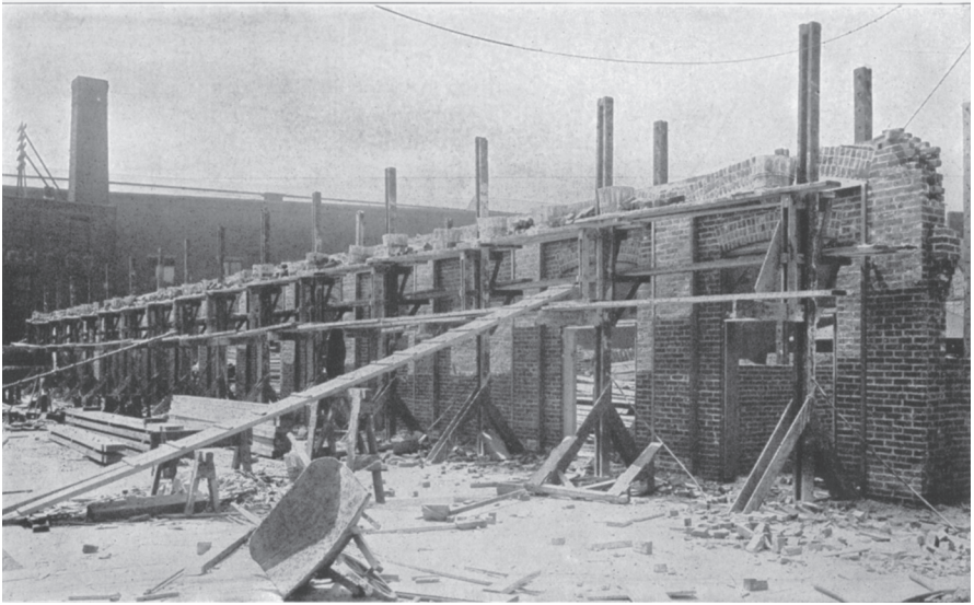
Abb. 8 a: Gilbreth: Baustellenfoto
